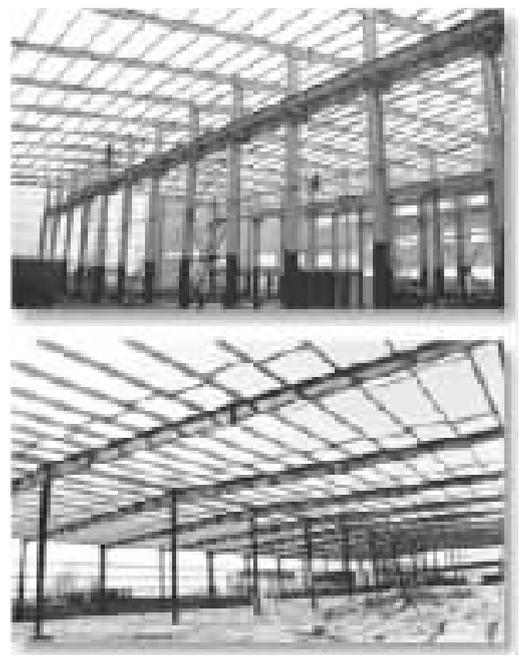
图 1.2.3 轻钢工业厂房门式刚架
