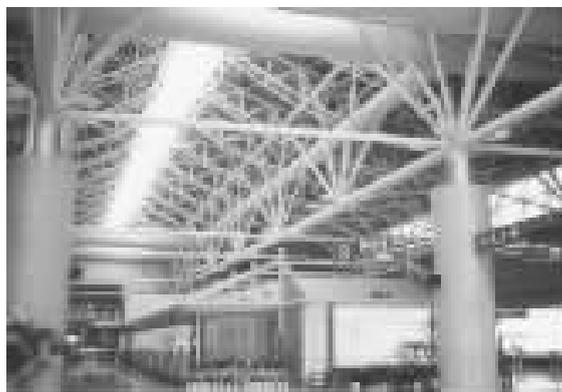
图 1.2.7 南京航空港直接焊接管结构
