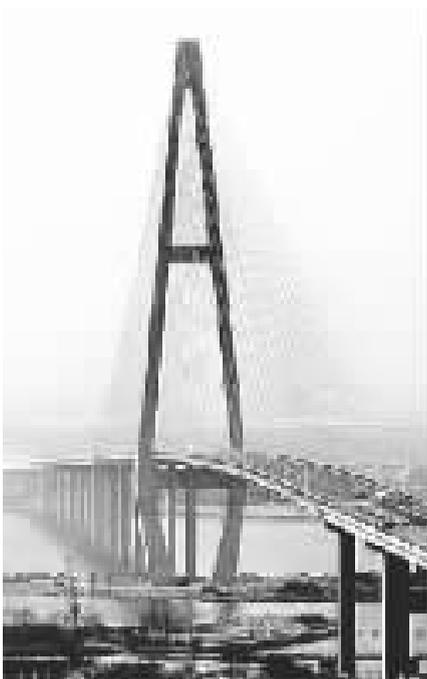
图 1.2.2 独塔斜拉桥——海河大桥
